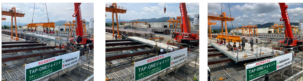
写真 2 実物大床版を用いた施工試験
