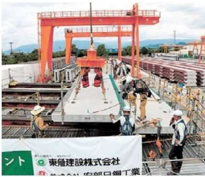
プレキャストのプレストレストコンクリート床版を用いた施工試験。本巢市曾井中島、安部日鋼工業岐阜本巢工場
