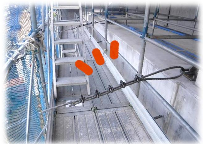
他社のワイヤーブリッジが昇降階段付近に突出していたので、ピンクリボン等をつけて目立たせて注意喚起をしましょう。
