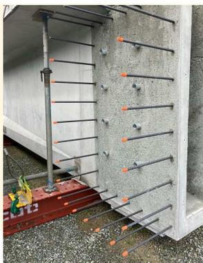
完成した桁の鉄筋にキャップが取り付けられていました！
