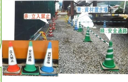
カラーコーンの色分けによる作業ヤード区分
