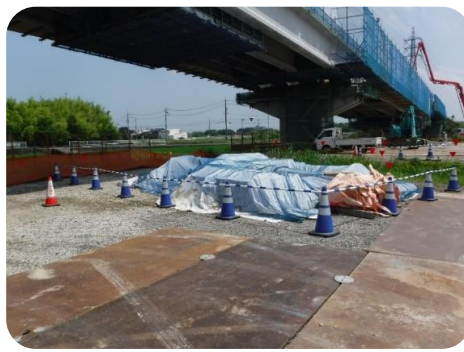
資材は青のカラーコーンに囲われ、きれいに整理整頓されていました。 ネットを被せて散乱を防ぐ対策もとられています。
