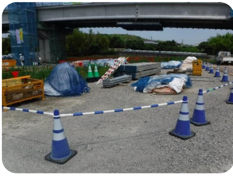
資材は青のカラーコーンに囲われ、きれいに整理整頓されていました。 ネットを被せて散乱を防ぐ対策もとられています。
