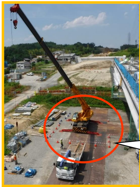
資材は青のカラーコーンに囲われ、きれいに整理整頓されていました。 ネットを被せて散乱を防ぐ対策もとられています。
