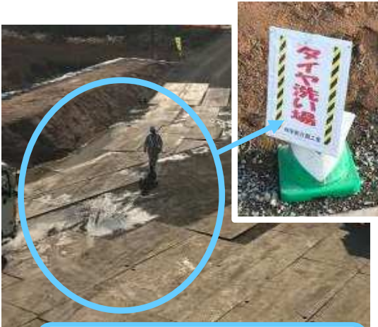
タイヤ洗い場を設け粉じん対策されていました☆
