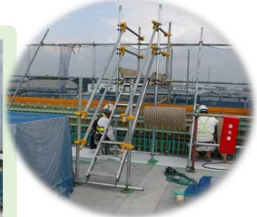
朝顔がないところで手摺を跨いでいる作業員がいました。墜落・転落防止のために、朝顔がないところにも渡りの昇降設備があるといいですね。
