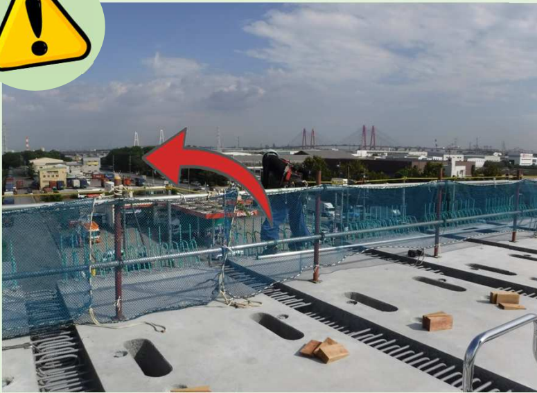
朝顔がないところで手摺を跨いでいる作業員がいました。墜落・転落防止のために、朝顔がないところにも渡りの昇降設備があるといいですね。
