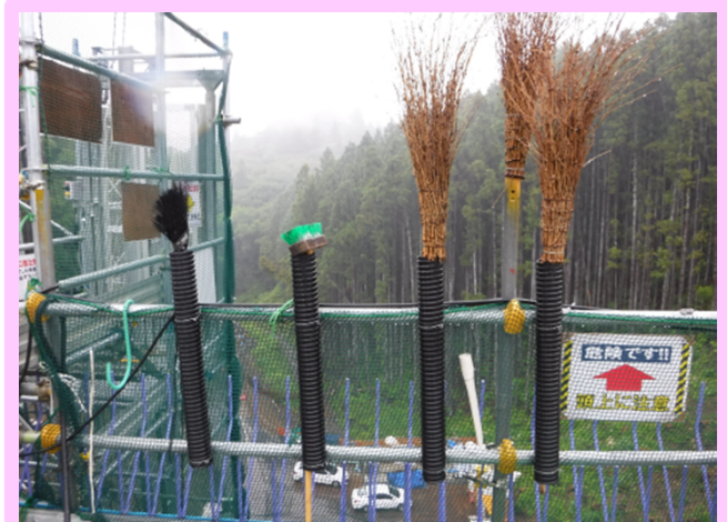
現場で使用する掃除用具が作業の妨げにならないよう筒状パイプを使って整頓されていた良かったです。
