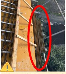
切断した鉄筋がブラケットサポート上に 置かれていました。 落下の恐れがあるので撤去しましょう!
