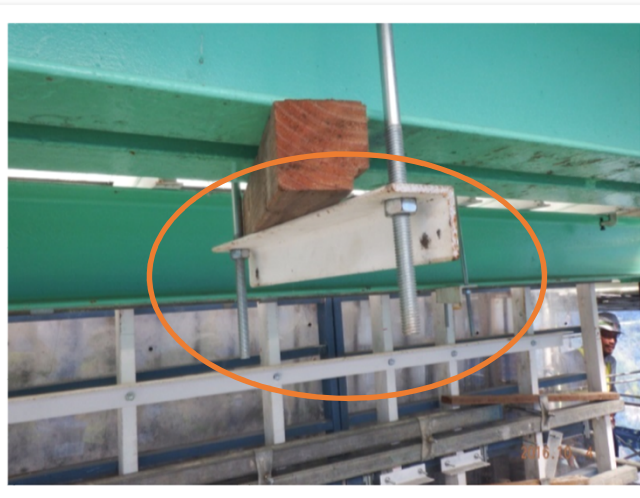
↑ 型枠固定ボルトが飛び出している ので、先端の保護をしてください。
