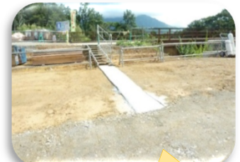
見学用足場への通路をコンクリートで整備しています。
