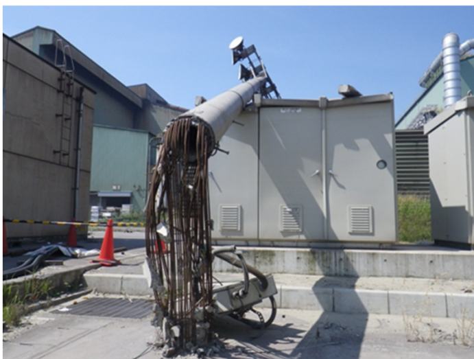
電柱の倒壊
