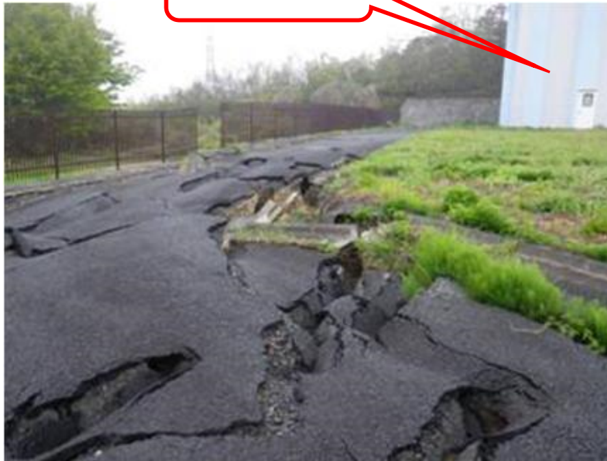
PCタンク周辺の地盤
