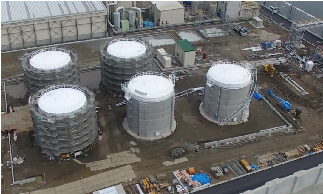
再建された気仙沼燃油タンク
