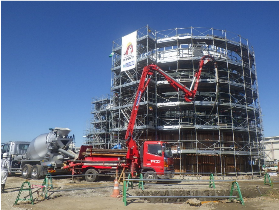
(3) コンクリートの打設
