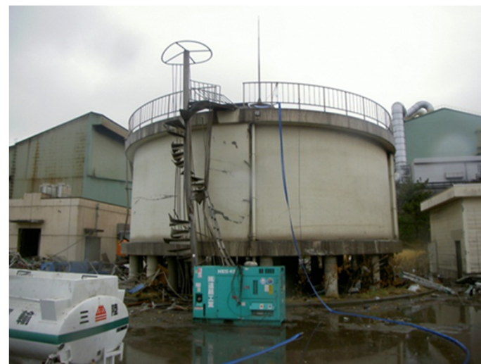
給水形跡あり （4/19の写真より）
