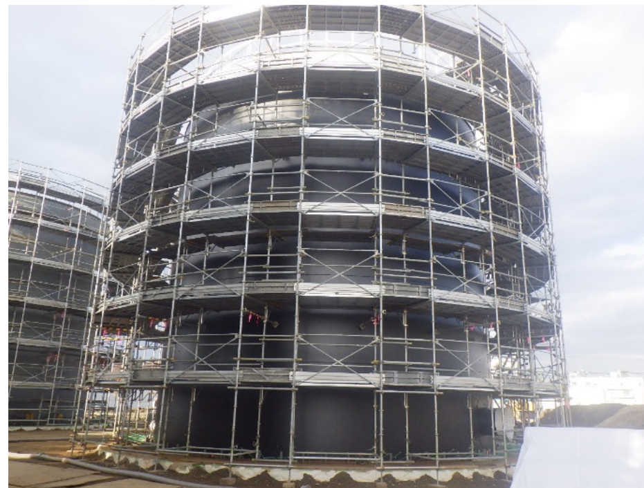
(2) 鋼製タンクの製作
