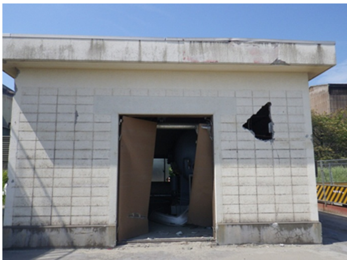
ポンプ室外部
