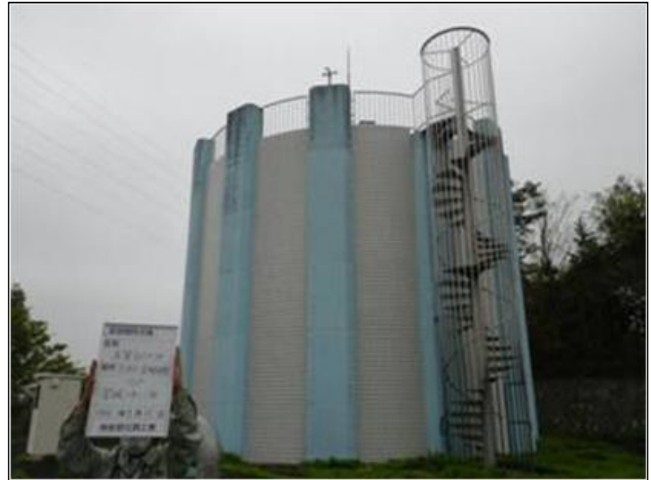
PCタンクは無被害
