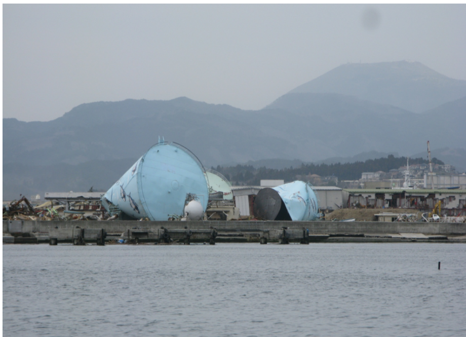
被害を受けた鋼製燃油タンク
