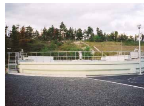
ポストテンション方式プレキャスト下水処理槽 沿岸部の塩害対策
